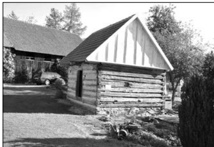
Pohled na špýchar po obnově a před dokončením úprav povrchu a spár, stav v roce 2019, foto VK
